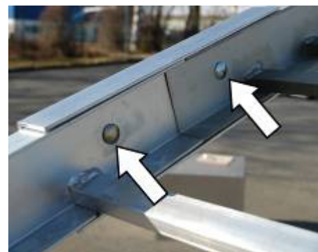
Afb. 68: Schroeven controleren
