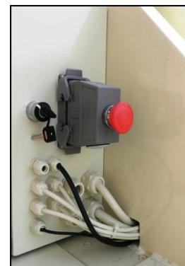
Figuur 39; Noodbediening/LMB sleutel.
