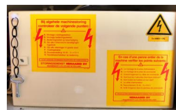
Figuur 42; Storing instructie Elektrokast.
